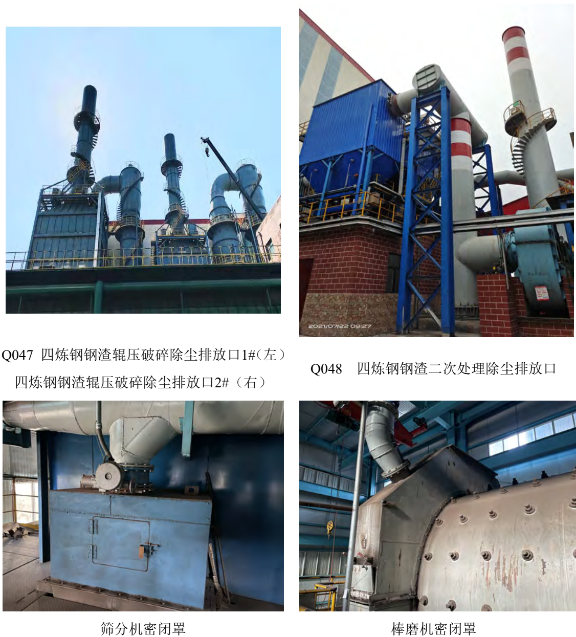
图 4.1-6 钢渣处理废气处理措施及排气筒设置情况照片
