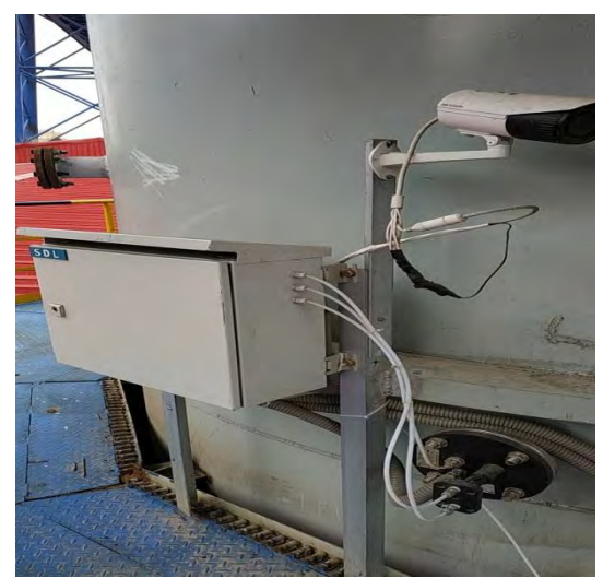
4#转炉二次除尘在线监测设备
