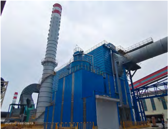
Q041 四炼钢精炼炉除尘排放口
