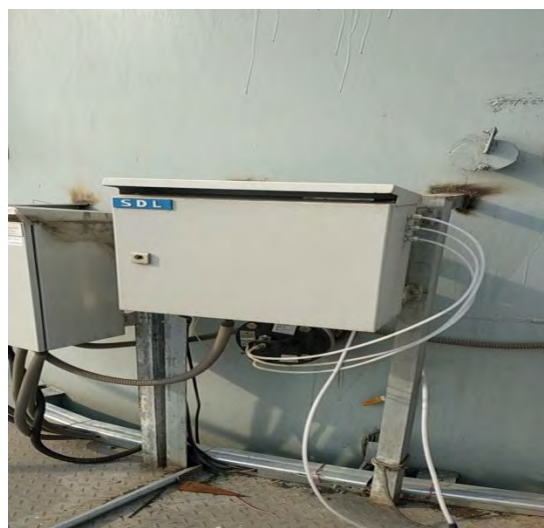
5#高炉出铁场除尘在线监测设备
