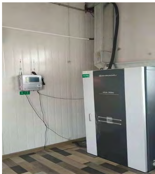
4#烧结脱硫在线监测设备
