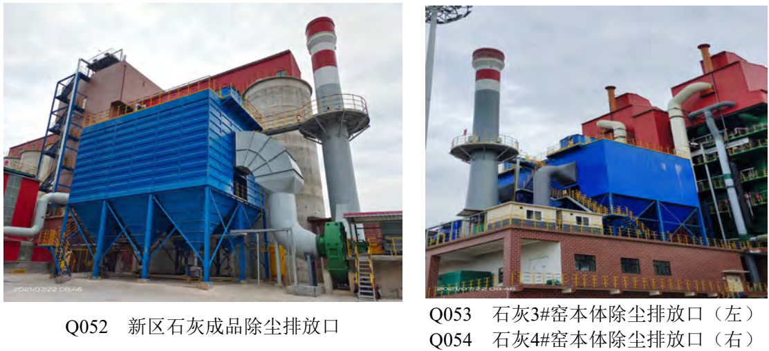
图 4.1-5 石灰窑废气处理措施及排气筒设置情况照片
