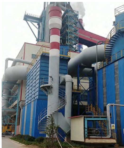
Q032 5#高炉炉顶除尘排放口
