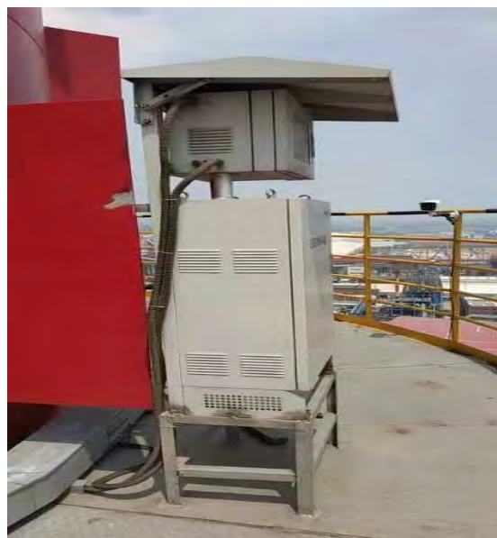
4#烧结脱硫在线监测设备
