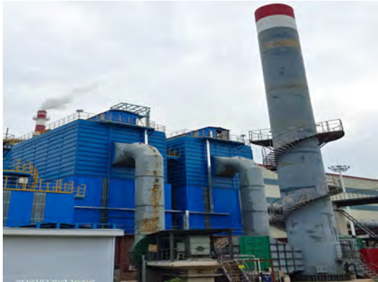
Q044 四炼钢铸铁机除尘排放口
