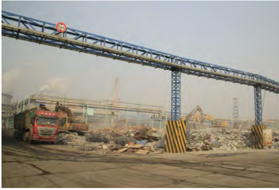
石横特钢450m 3 高炉拆除现场
