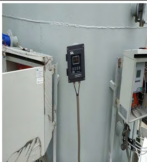
4#高炉矿槽除尘在线监测设备
