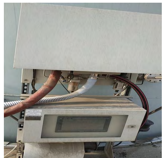
5#高炉出铁场除尘在线监测设备
