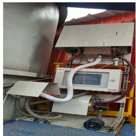
4#转炉二次除尘在线监测设备
