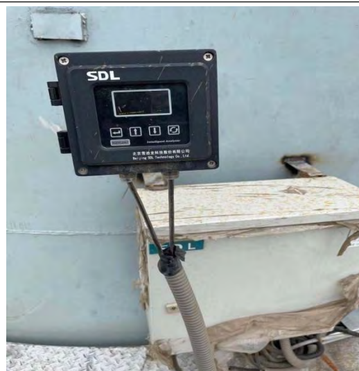
4#高炉出铁场除尘在线监测设备
