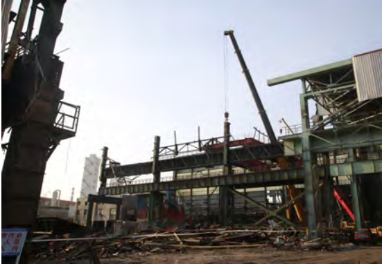
石横特钢2#45t转炉拆除现场
