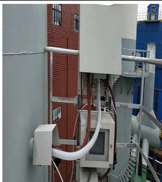
4#高炉矿槽除尘在线监测设备
