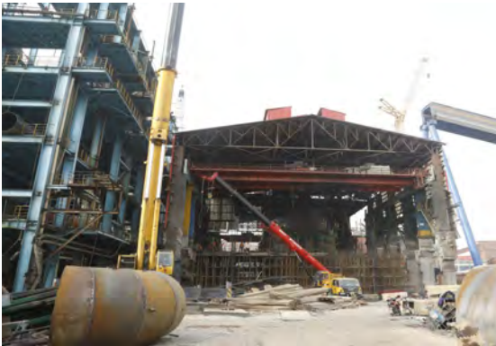
3#1080m 3 高炉拆除现场
