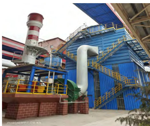
Q022 四炼铁矿槽转运站除尘排放口
