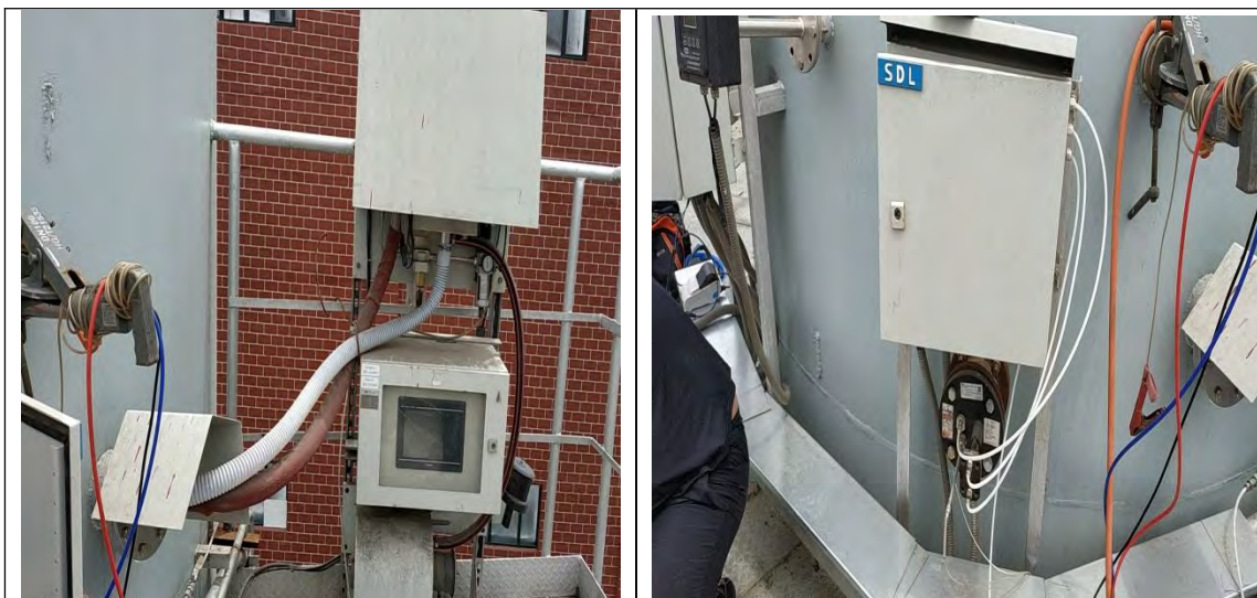
5#高炉矿槽除尘在线监测设备
